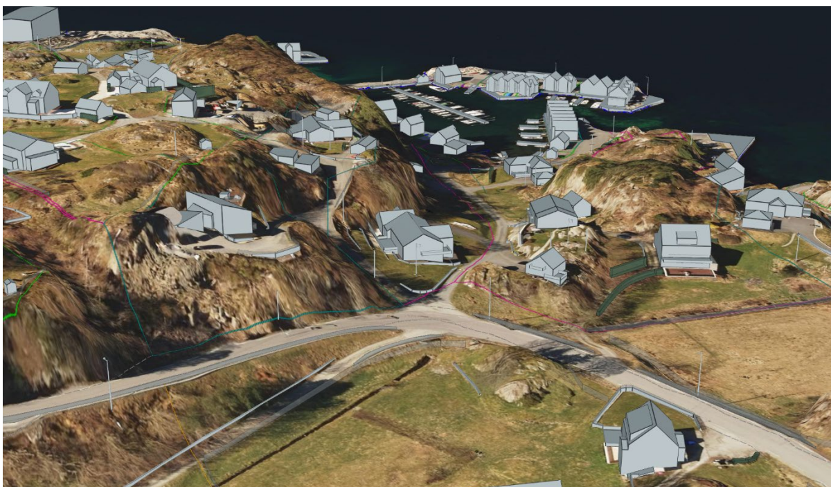
Figur 4 Utklipp frå "Kommunekart 3D" som syner vegkrysset frå fylkesveg. Avkøyrse mot to av dei eksisterande einingane er svert bratt.
