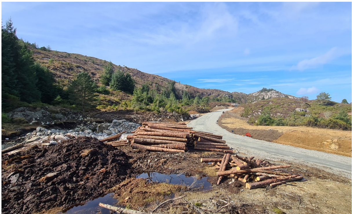
Figur 6: Vegetasjonsrydding i forbindelse med veiutbygging.
