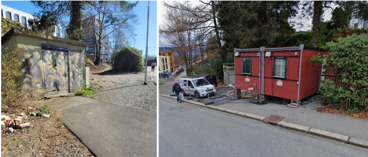
Figur 23: Trafostasjon og grusplass sørvest i planområdet.
