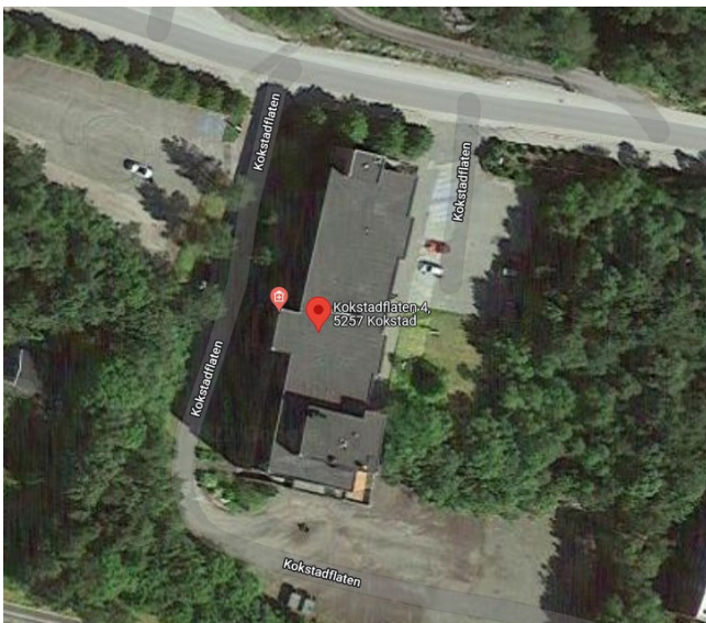
Bilde: 4 Eksisterende situasjon
