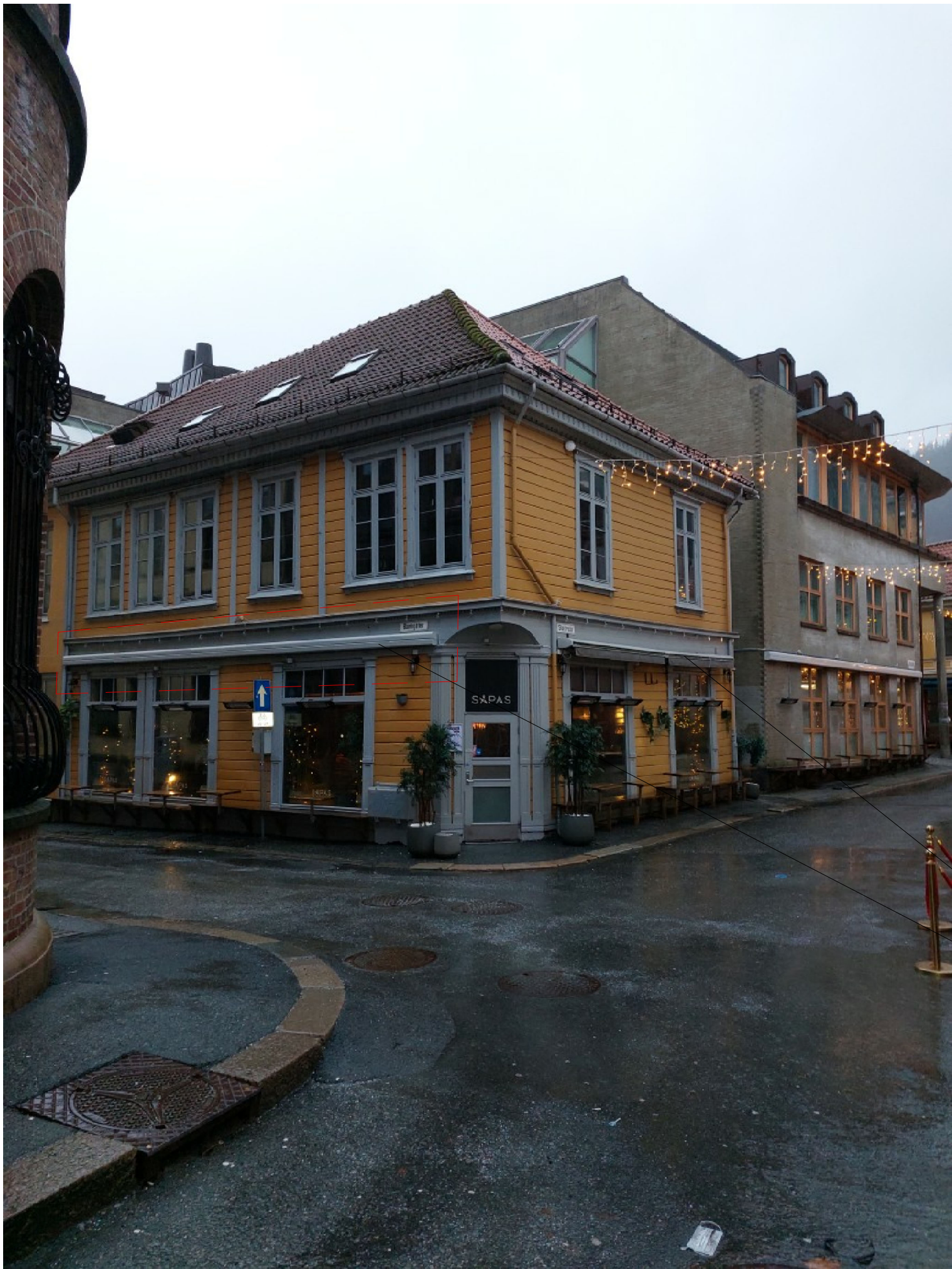
Bilde av fasade mot Skostredet etter montering av markiser.
