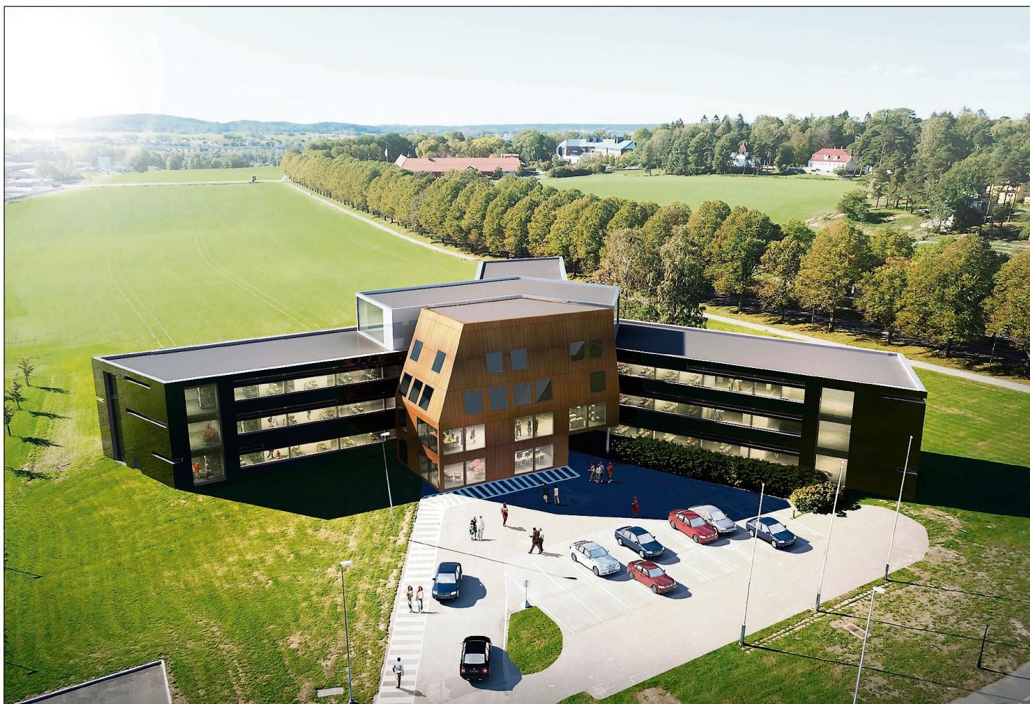
STJERNEBYGGET: Slik blir nye Stjernebygget seende ut etter totalrenoveringen.
